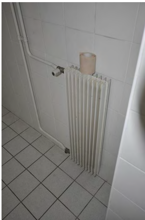
Slika 15: Fotografija tipičnih grelnih teles na objektu. Vir: Lastni arhiv pridobljen na dan ogleda.
